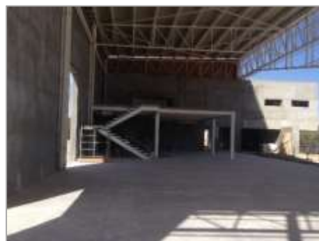
Interior nave (vista sur)
