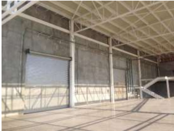
Interior Nave (cortinas y suministros)
